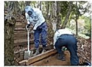
発生材を活用した小破修繕
